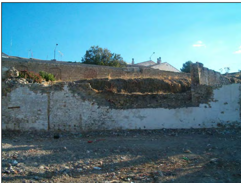
Lam. 15. Localización y estado previo de la finca n 23205 desde el Área 3.
