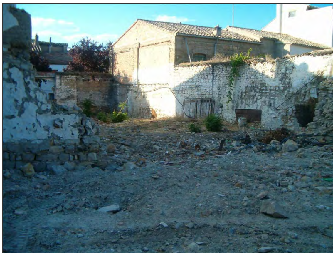
Lam. 1. Estado Área 1 tras la demolición.
