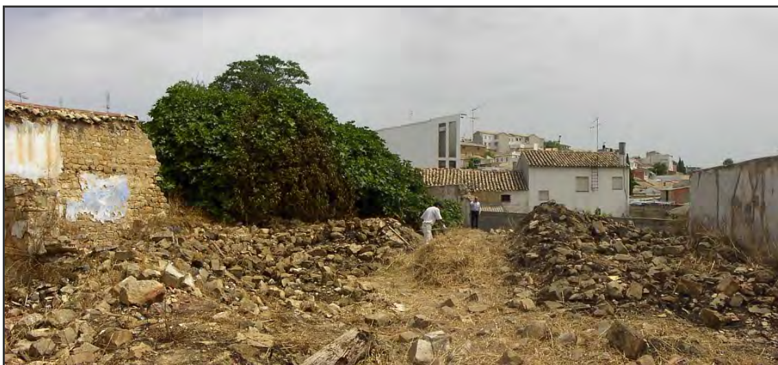
Lam. 3 y 4.- Estado del solar previo al inicio de la intervención.
