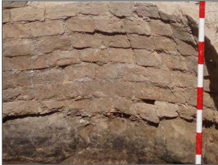
Lam.16.- Detalle del sistema constructivo de la bóveda del horno.
