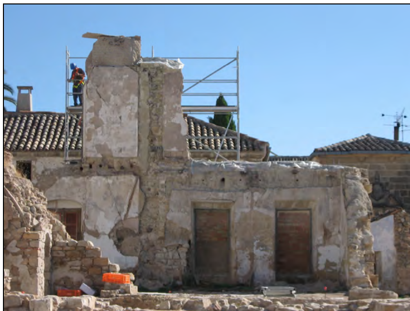
Lám., 47. Trabajos de demolición parcial de muro perimetral, verano de 2009.
