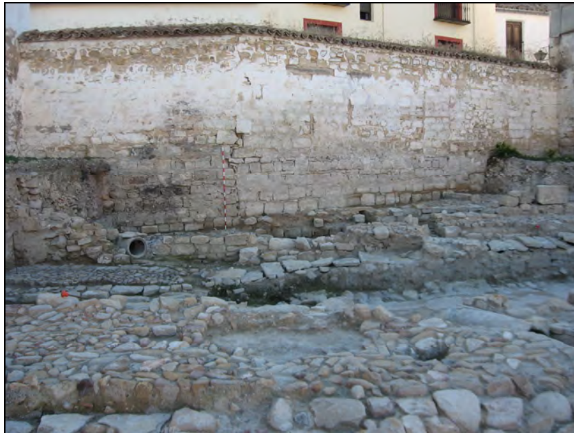
Lám., 52. Muro-fachada oeste de la parcela adelantado sobre la Calle Narváez.
