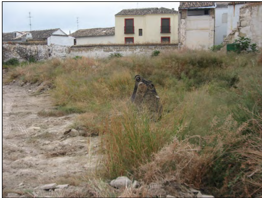
Lám., 2. Retirada de la vegetación y escombros con medios mecánicos.
