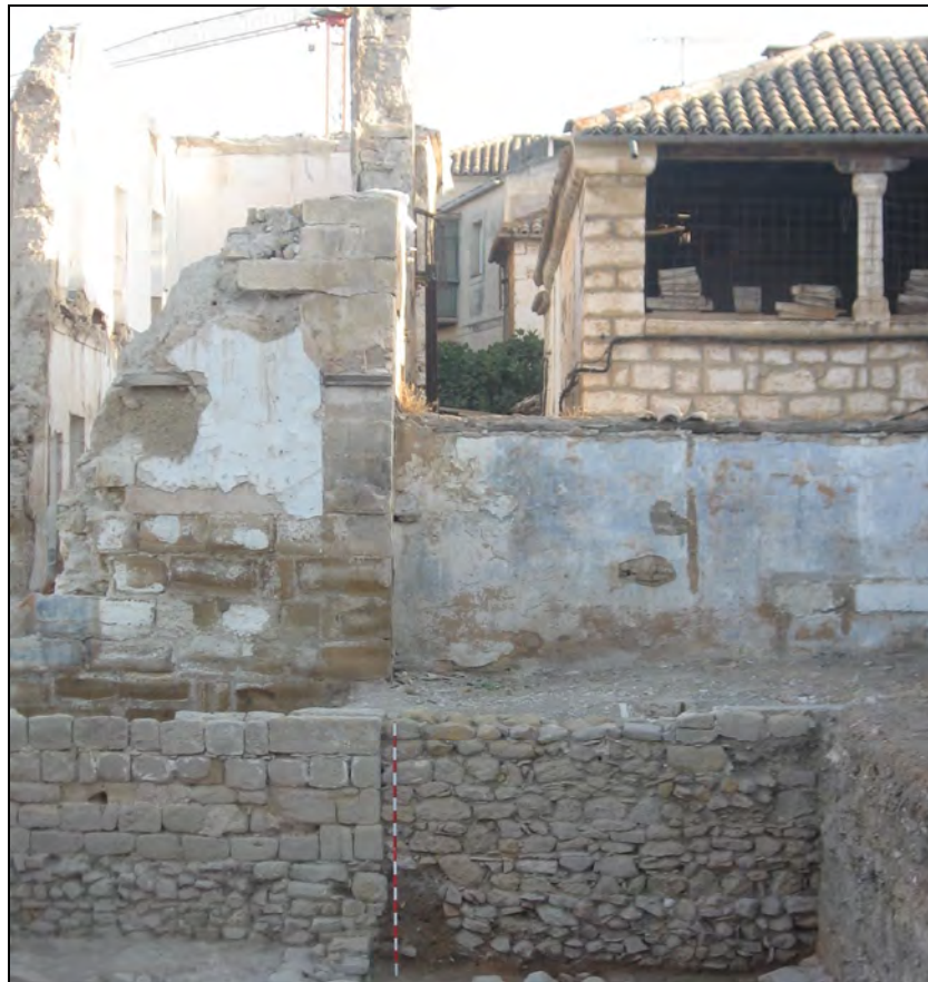
Lám., 51. Detalle vértice sureste del palacio renacentista demolido.
