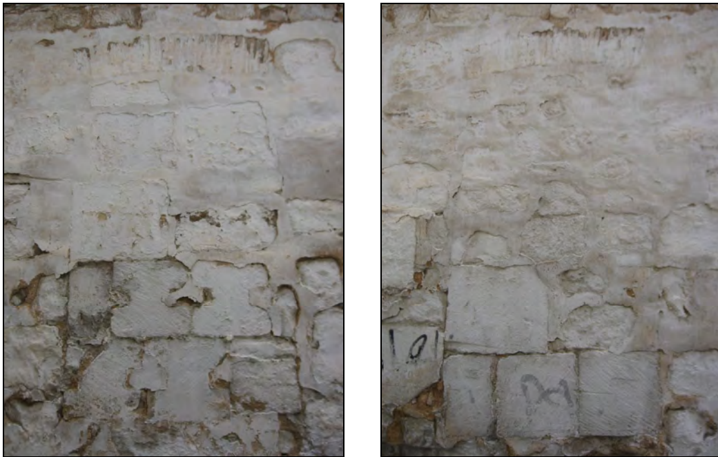
Lám., 33 y 34. Detalle de las ventanas cegadas con piedras decoradas.
