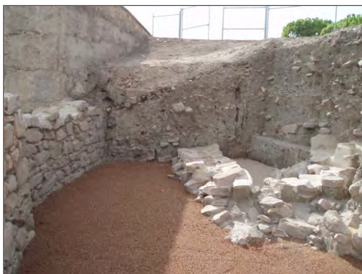
Lams. 23 y 24. Detalle de la superposición de niveles erosivos sobre los lienzos 3A y 4
