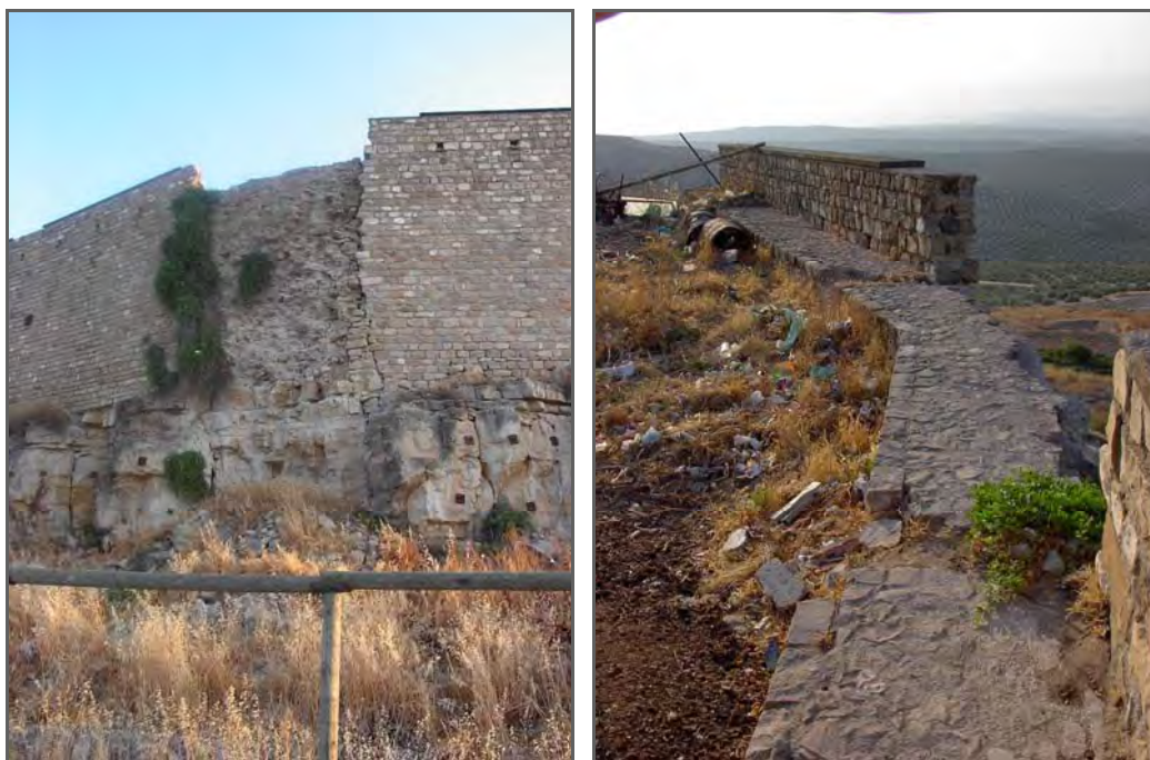
Lams. 3 y 4. Estado de conservación del tramo intervenido.
