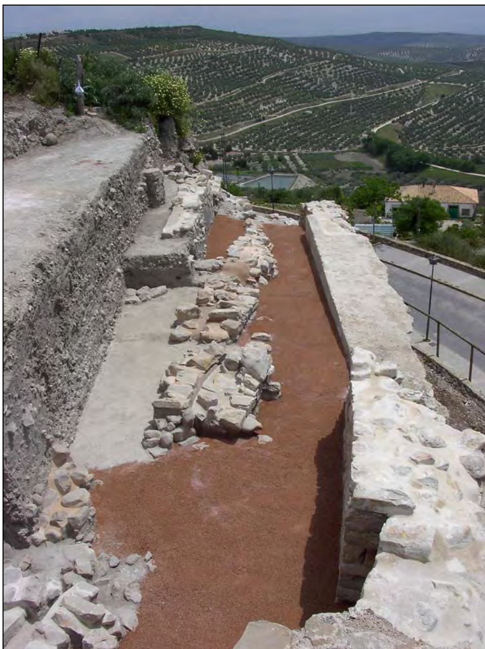
Lam. 37. Vista general del área de intervención en el estado actual
