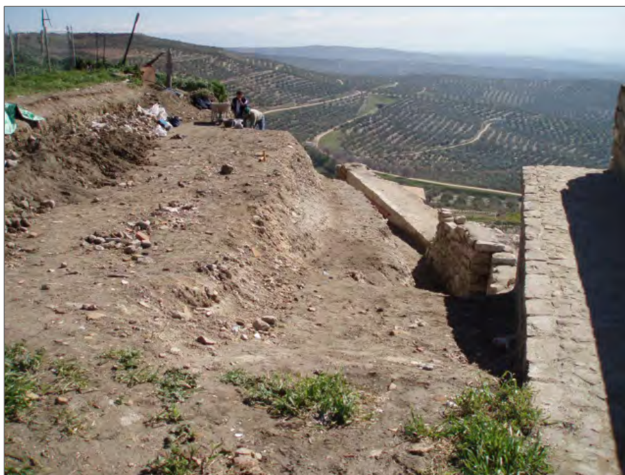
Lam. 9. Vista general de taludes interiores.
