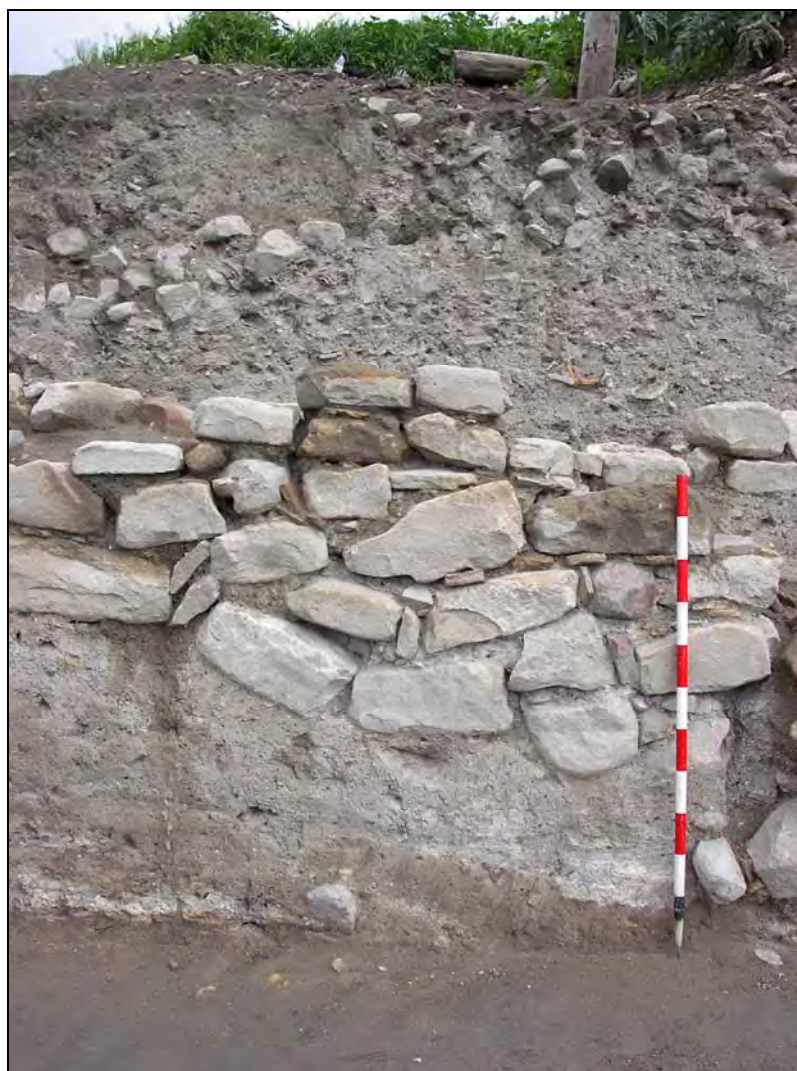
Lam. 26. Sistema de cimentación de la E-7A.
