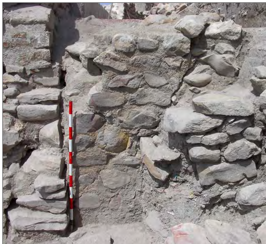
Lam. 17. Estructura 12, muro contención construido en 1985.
