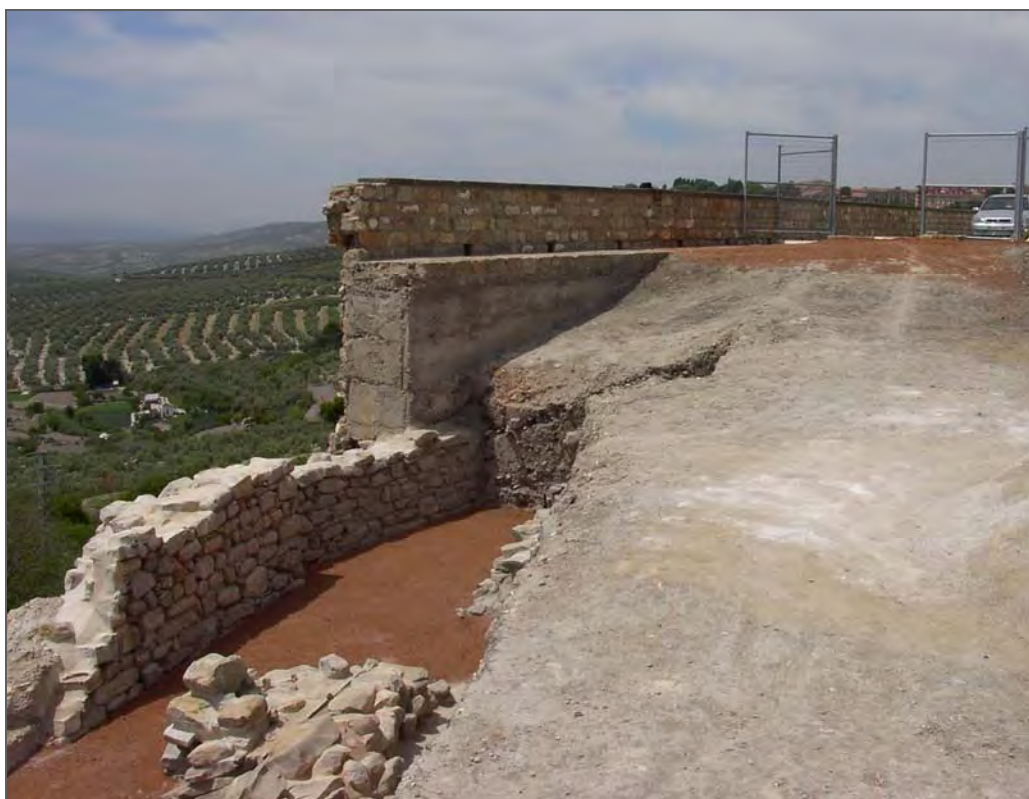
Lam. 33. Vista general del área de intervención estado actual
