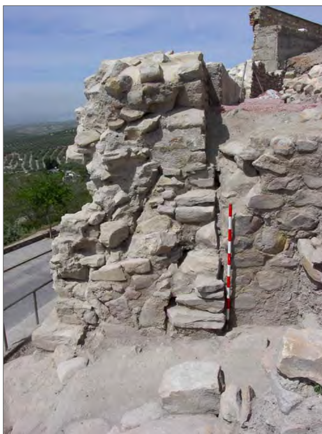
Lam. 16. Sección oriental lienzo E-8B. Estado actual.
