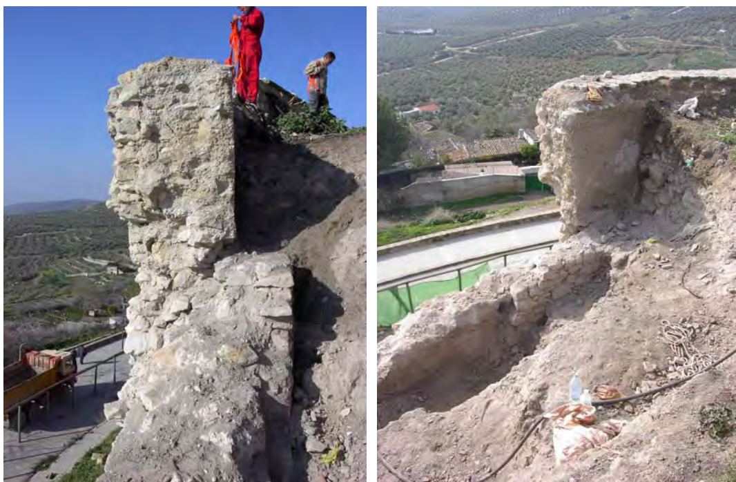
Lams. 7 y 8. Superposición del muro de hormigón sobre los lienzos de fortificación medievales.
