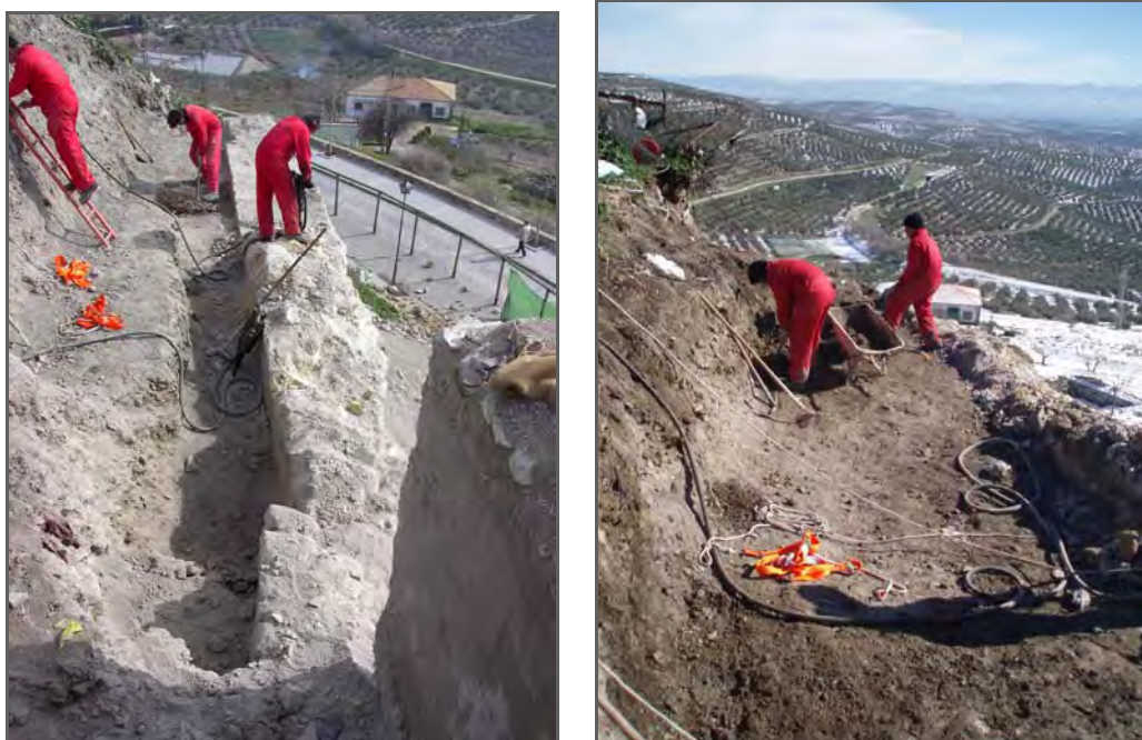
Lams. 5 y 6. Proceso de demolición del muro de hormigón.
