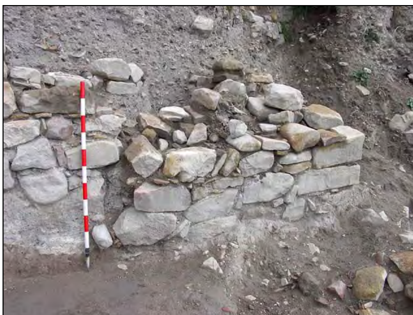
Lam. 25. Esquina CE-1. Puede apreciarse la fractura del paramento de la E-7A, como consecuencia de la presión de los sedimentos.
